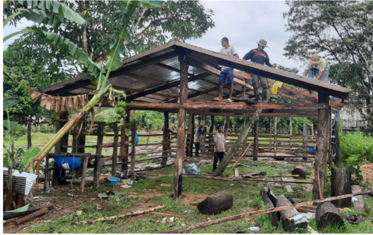
Figure 2: Construction of buffalo dairy in Sambour Akphivoat CPA
